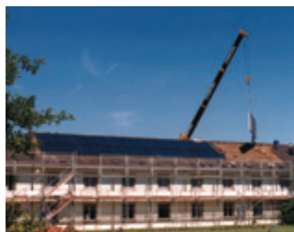
FIGURA 2.37. Arquitetura solar no telhado, Alemanha. Os coletores foram feitos por encomenda no tamanho exato para cobrir o telhado. Nesses casos os coletores tem a função de aquecer água e isolar a edificação, para que não perca calor de dentro para fora.
