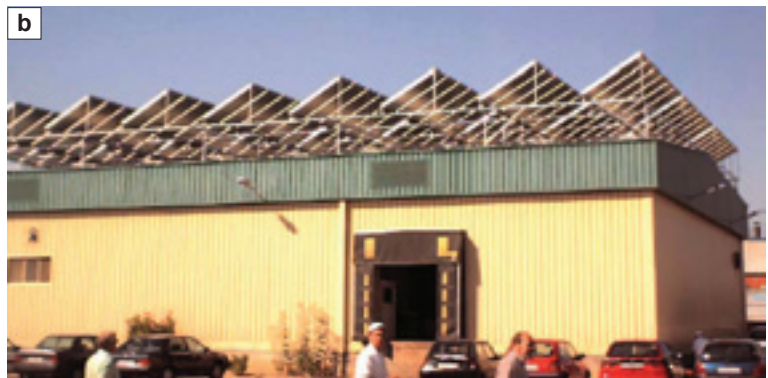
FIGURA 7.12. Em (a), coletores apoiados em suporte inclinado sobre o telhado. Em (b), coletores apoiados em suporte inclinado apoiado sobre a laje.
