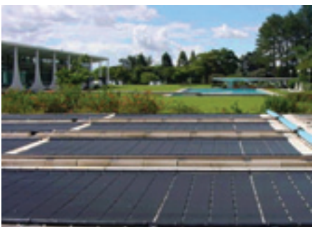
FIGURA 2.27. Palácio da alvorada Brasília, Distrito Federal. Observe que as placas estão apoiadas no chão e a relação entre área da piscina e área instalada de coletores é praticamente 1:1.
