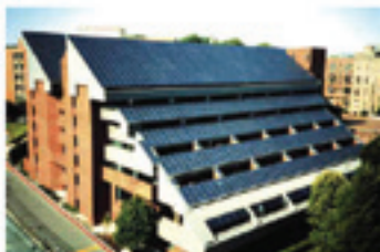
FIGURA 1.19. Universidade na Alemanha que utiliza sistemas fotovoltaicos conectados à rede elétrica. Observe que o conjunto das placas está sobre o telhado integrado à arquitetura do prédio.
