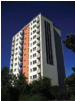
FIGURA 2.29. Arquitetura solar na fachada. Alemanha. Sistema para aquecimento de água com capacidade diária de 3000 litros de água.
