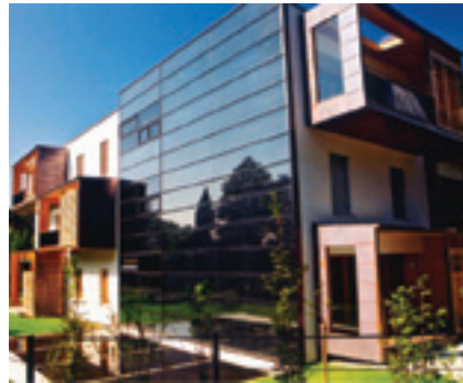
FIGURA 1.2B. Arquitetura solar na fachada, Áustria. Observe que os coletores solares estão na fachada. Esse sistema combina duas funções: aquecer o ar e a água.
