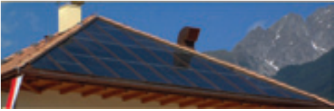
FIGURA 2.33. Arquitetura solar no telhado. Alguns coletores solares foram feitas no formato triangular, permitindo a integração aos cantos do telhado.
