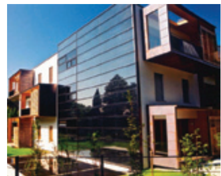
FIGURA 2.36. Arquitetura solar na fachada, Áustria. Observe que os coletores solares estão na fachada. Esse sistema combina duas funções: aquecer o ar e a água.
