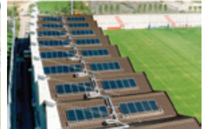
FIGURA 2.34. Arquitetura solar em estádios de futebol. Vistas aéreas dos coletores solares instalados sobre a cobertura das arquibancadas.
