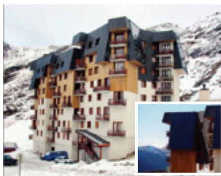
FIGURA 2.35. Arquitetura solar no telhado e fachadas, França. Observe que a inclinação evita o acumulo de neve e absorve as radiações solares difusas e diretas.
