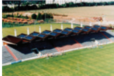
FIGURA 2.34. Arquitetura solar em estádios de futebol. Vistas aéreas dos coletores solares instalados sobre a cobertura das arquibancadas.
