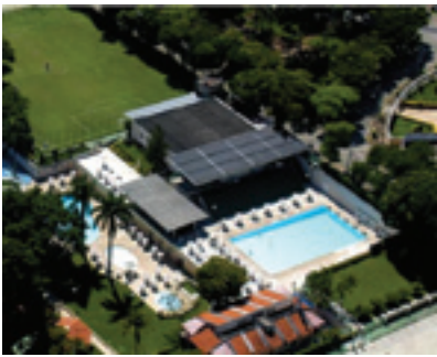
FIGURA 2.25. Associação do pessoal da Caixa Econômica Federal, Belo Horizonte, Minas Gerais. Observe que as placas estão orientadas em uma única direção e área instalada de coletores é menor que a área da piscina.
