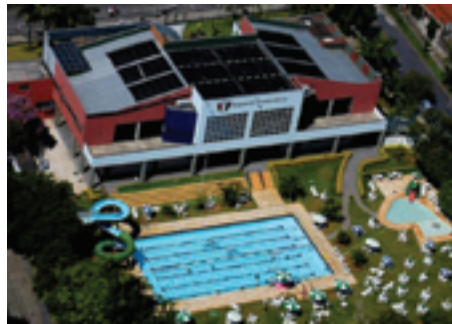
FIGURA 2.26. Esporte Clube Sírio, Belo Horizonte, Minas Gerais. Observe que as placas estão orientadas para diferentes regiões e a relação entre área da piscina e área instalada de coletores é praticamente 1:1.
