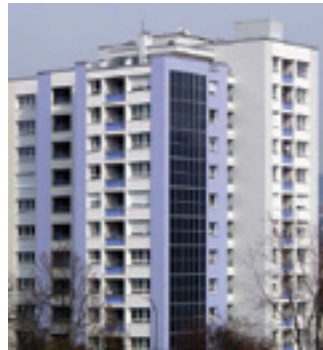
FIGURA 2.30. Arquitetura solar na fachada instalados em apartamentos na cidade de Esslingen, Alemanha. Sistema para aquecimento de água com 282 m 2 de coletores.
