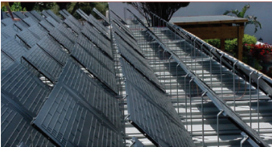
FIGURA 4.19. Instalação de painéis solares termodinâmicos.
