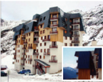
FIGURA 1.2A. Arquitetura solar no telhado e fachadas, França. Observe que a inclinação evita o acúmulo de neve e absorve as radiações solares difusas e diretas.
