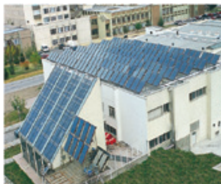
FIGURA 2.32. Os coletores estão apoiados na fachada do edifício e no telhado formando uma conjunto de baterias. As distâncias entre as baterias de coletores devem levar em conta a projeção da sombra dos coletores.
