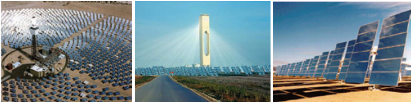
FIGURA 1.4. No mundo existem cerca de 50 usinas solares térmicas que utilizam esse princípio de funcionamento em diferentes estágios de construção.
