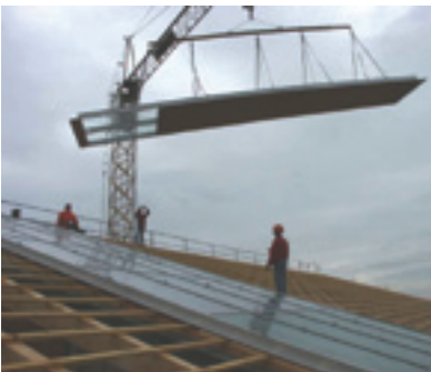
FIGURA 2.37. Arquitetura solar no telhado, Alemanha. Os coletores foram feitos por encomenda no tamanho exato para cobrir o telhado. Nesses casos os coletores tem a função de aquecer água e isolar a edificação, para que não perca calor de dentro para fora.
