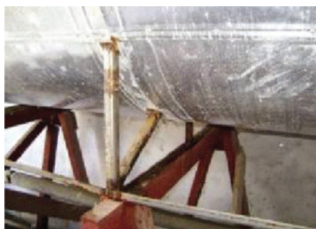
Figura 9.4.3 • Ocorrência de oxidação nos suportes de alguns reservatórios
