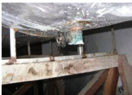
Figura 9.4.3 • Ocorrência de oxidação nos suportes de alguns reservatórios
