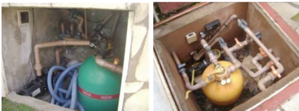
Figura 9.3.6 • Exemplos de equipamentos em casas de máquinas
