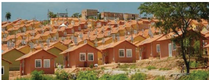
Figura 6.1 • Projeto Cemig/Cohab (MG) de aquecimento solar em Betim (Costa, 2009)
