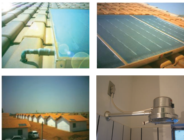
Figura 4.5 • Sistema de aquecimento de água híbrido em HIS
